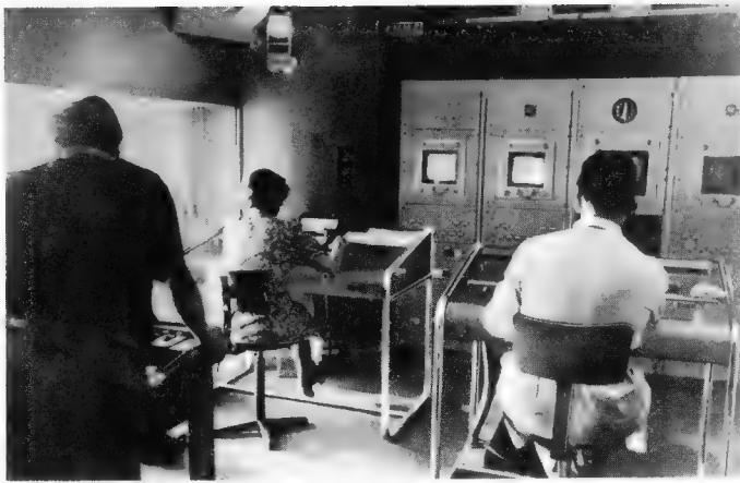
Links: Fernseh-Regieraum im Großen Studio der Reichspost am Reichskanzlerplatz in Berlin; rechts das Bildmischpult, links daneben das Tonmischpult
